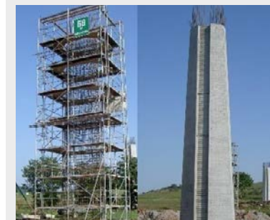
Abb. 38: Brückenpfeiler aus Stahlbeton | Quelle: Störfix - commons.wikimedia.org, CC BY-SA 3.0
