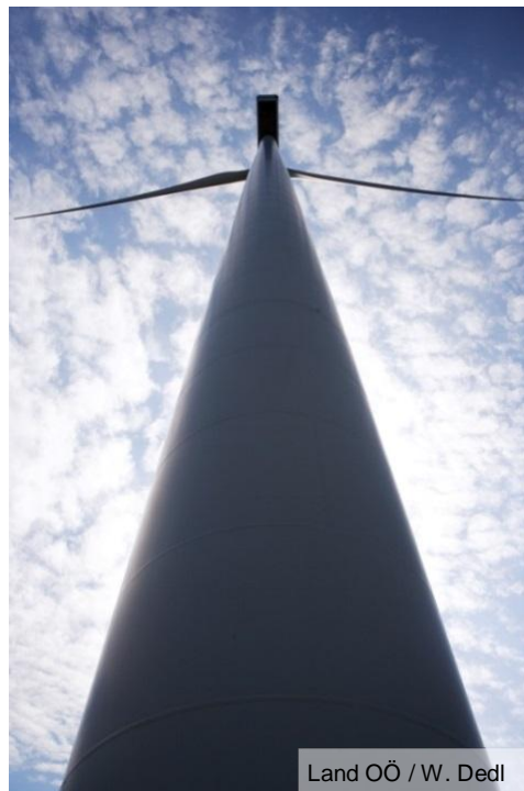
Abbildung 2: Windkraftanlage in Oberösterreich
